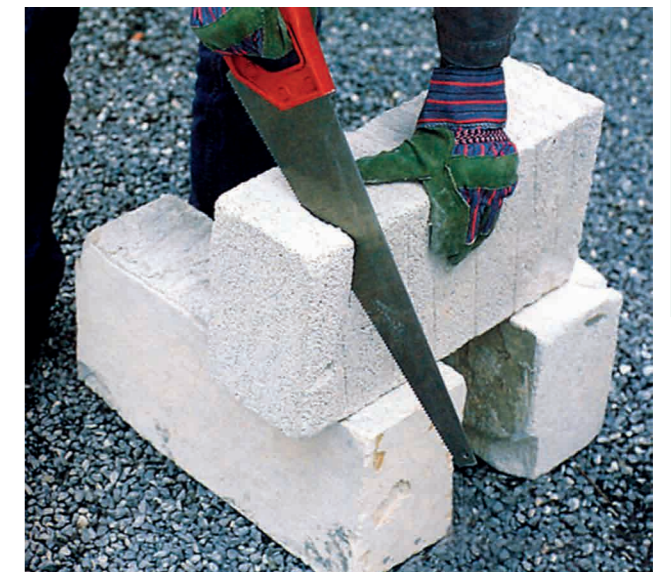
3-nji surat. Gazbeton bloklaryny dürli görnüşe getirmek işleri.
