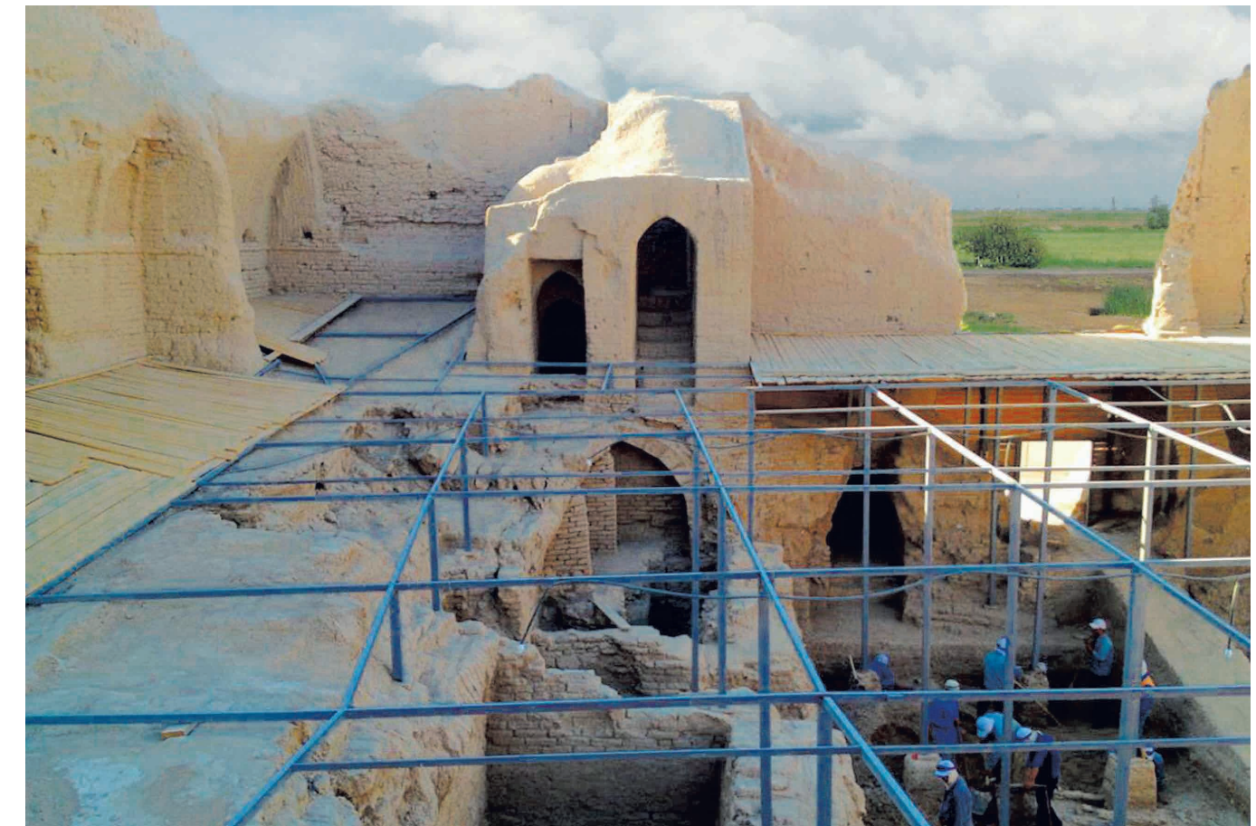
Interýerde wagtlaýyn gorag bassyrmasyň montajy Installation of a temporary protective canopy in the interior Монтаж временного защитного навеса в интерьере
